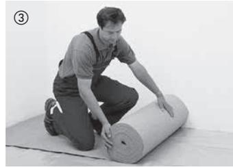
Pour l'isolation phonique et l'égalisation des petites aspérités, il convient de dérouler jusqu'aux bords un rouleau de liège de 2 mm d'épaisseur. D'autres sous-couches isolantes alternatives sont également disponibles parmi notre gamme d'accessoires. Le carton bitumé et la moquette ne se prêtent pas à l'isolation phonique. **Pour Parquet HARO Silent Pro® ne pas poser de sous-couche isolante supplémentaire. Ces sols ne sont pas compatibles avec la pose collée en plein.**
