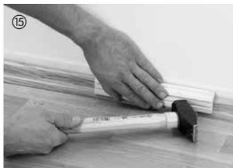
Une fois la pose terminée, il est impératif d'enlever les cales. Visser les plinthes (avec ou sans système à clips) – C'est terminé !
