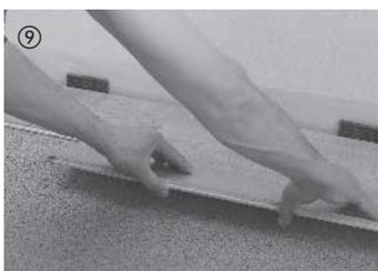
Les autres éléments sont posés lame par lame. Pour ce faire, les lames sont d'abord emboîtées en biais sur la longueur sous l'effet d'une légère pression exercée dans la liaison.
