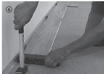
Les lames de la première rangée sont assemblées à l'horizontale sur le petit bout de la lame avec le marteau et la cale de frappe.
