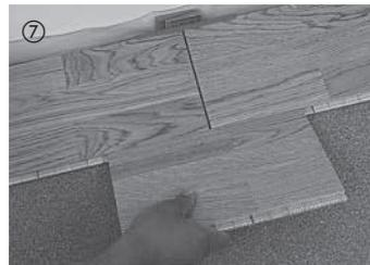
Remarque importante : Pour un assemblage exacte des éléments dans la zone frontale, il faut utiliser une coupe d'élément de recouvrement dans la zone du bord de longueur.
