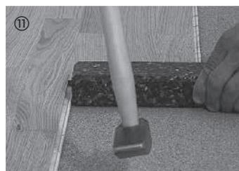
Chaque élément est ensuite assemblé à l'horizontale avec l'élément de droite par le petit bout de la lame à l'aide du marteau et de la cale de frappe ou avec la barre d'assemblage pour les éléments posés le long des murs.
