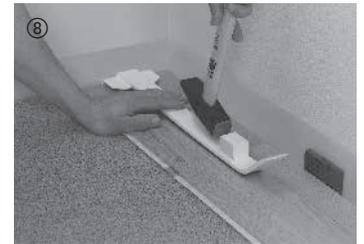
La dernière lame de la première rangée est coupée respectant le jeu de dilatation de 10–15 mm par rapport au mur et assemblée avec la barre d'assemblage. Pour commencer la prochaine rangée, il convient d'utiliser le reste de la première rangée. Ainsi on évite trop de chutes. Attention : décalage des joints en bout d'élément d'au moins 50 cm.
