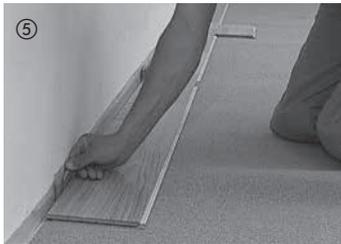
La première lame est posée au coin droit de la pièce et maintenue par des cales biseautées en PE (respecter un jeu de dilatation de 10–15 mm par rapport au mur). Les éléments sont toujours posés avec la languette côté mur.
